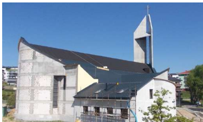
Budowa kościoła czerwiec 2013
