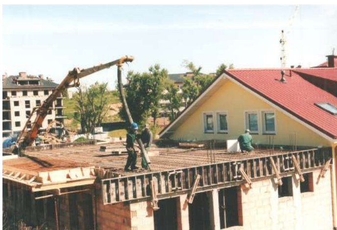
Dobudowa domu parafialnego 2006
