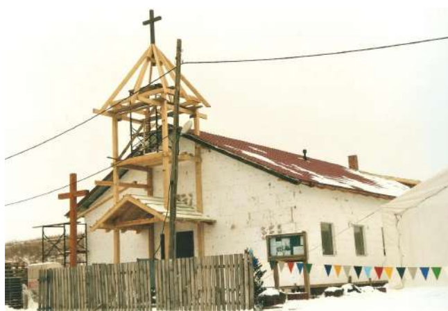
Budowa kaplicy luty 2003
