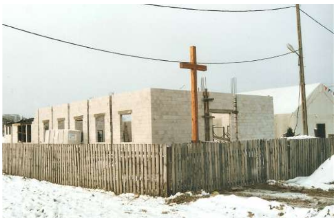
Budowa kaplicy grudzień 2002
