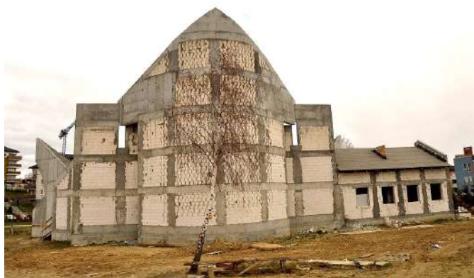
Budowa kościoła kwiecień 2012
