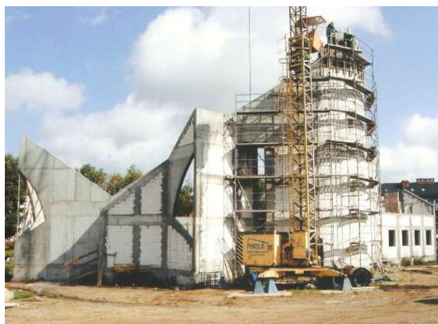
Budowa kościoła wrzesień 2010
